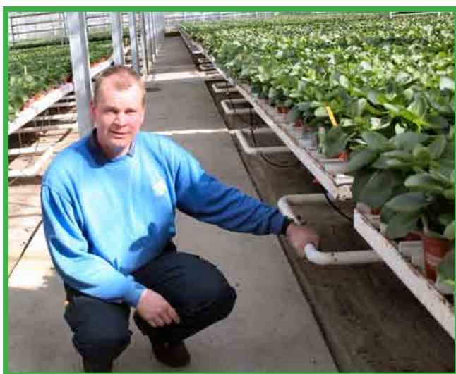
Mattias Svegin visar värmeelementen.
